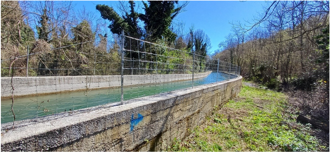
Figura 1 - Dettaglio opere eseguite con il lotto 1 (canale Maraldi)
