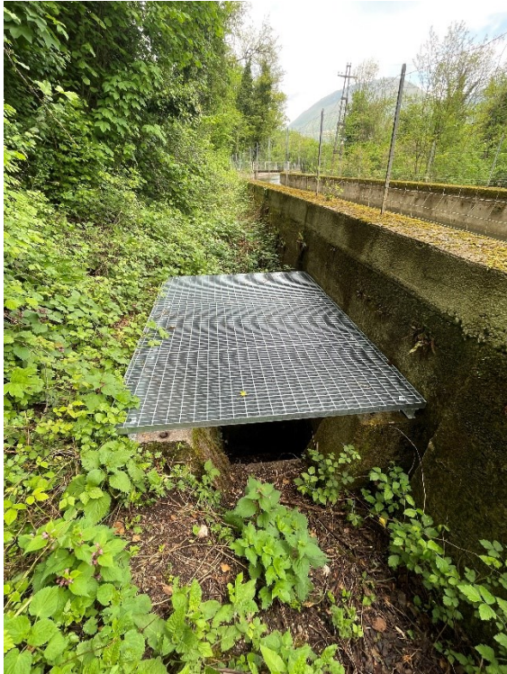
Figura 3 - Dettaglio opere eseguite con il lotto 2 (canale Maraldi)
