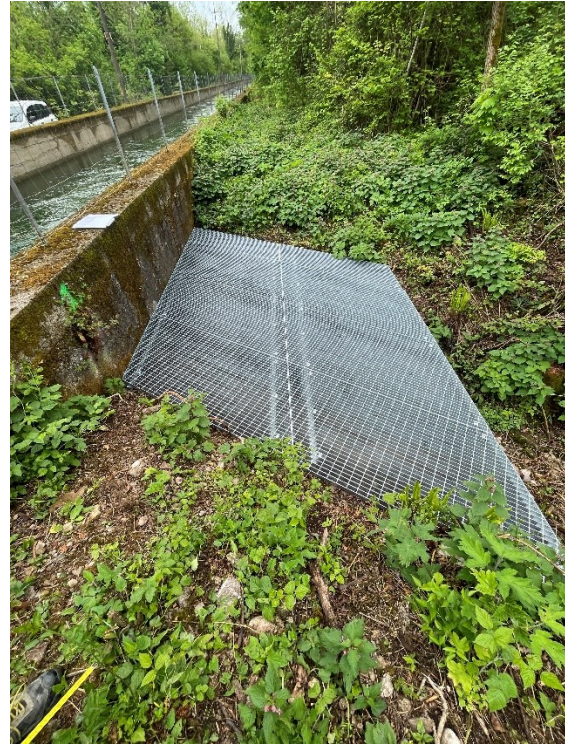
Figura 4 - Dettaglio opere eseguite con il lotto 2 (canale Maraldi)
