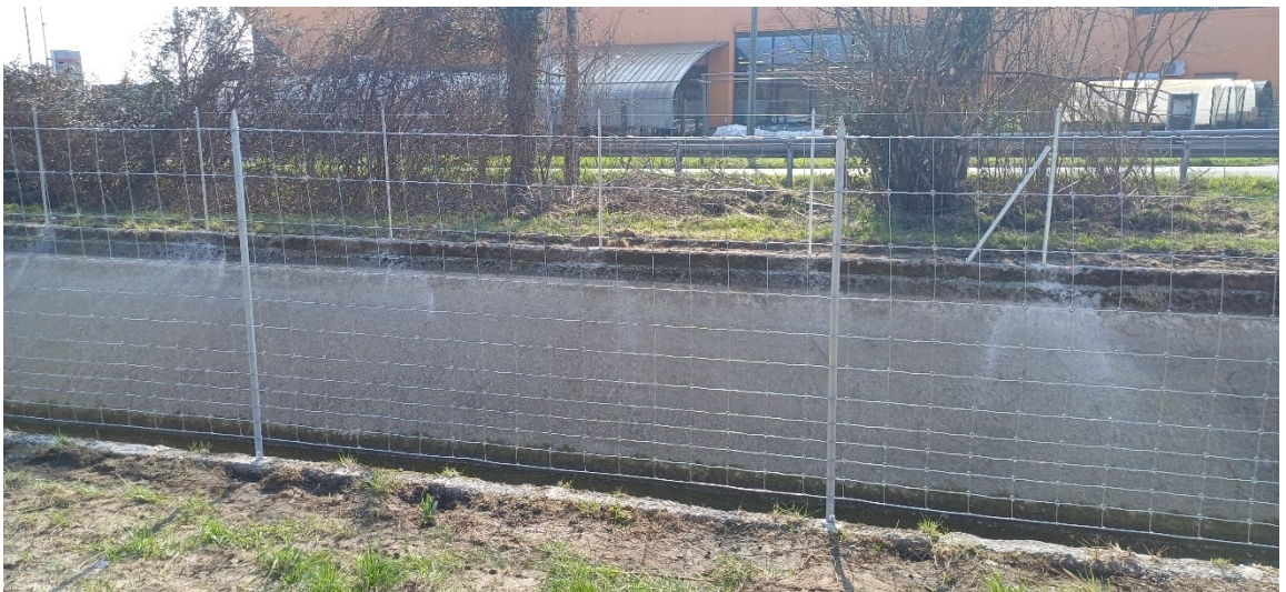
Figura 2 - Dettaglio opere eseguite con il lotto 1 (canale Istrago-Tauriano)
